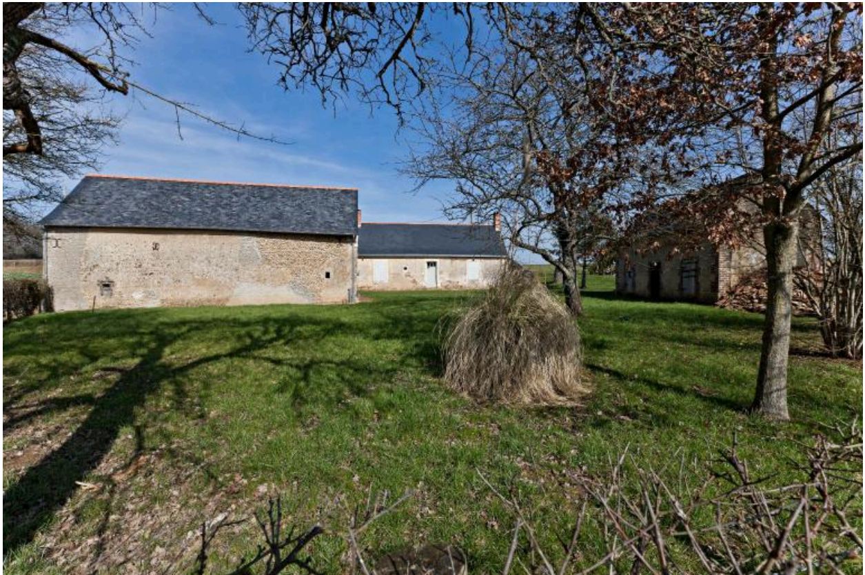
Bâtiments organisés autour d'une grande cour ouverte. La Basse Touvarie.
