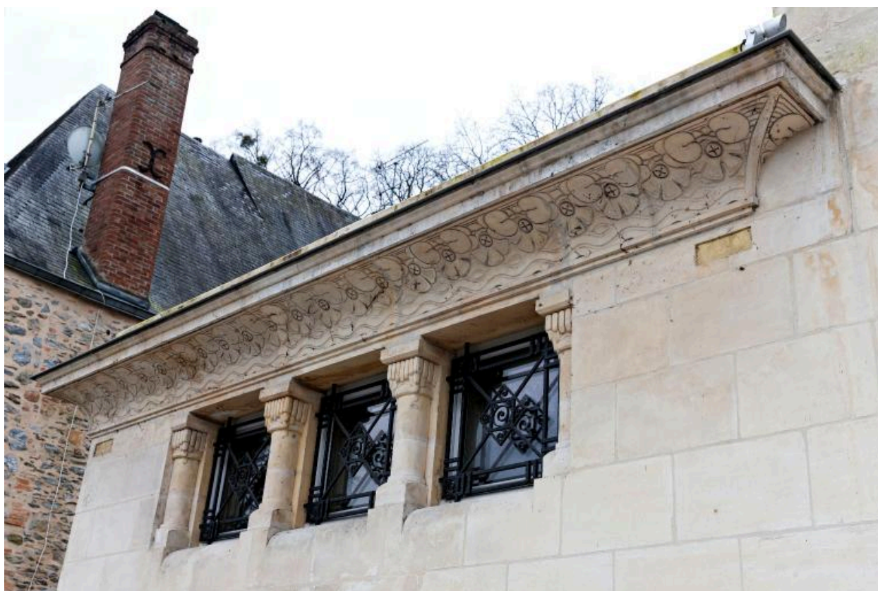
Les bains-douches restaurés. Elévation antérieure, extrémité sud, vue de détail : baies et corniche.
