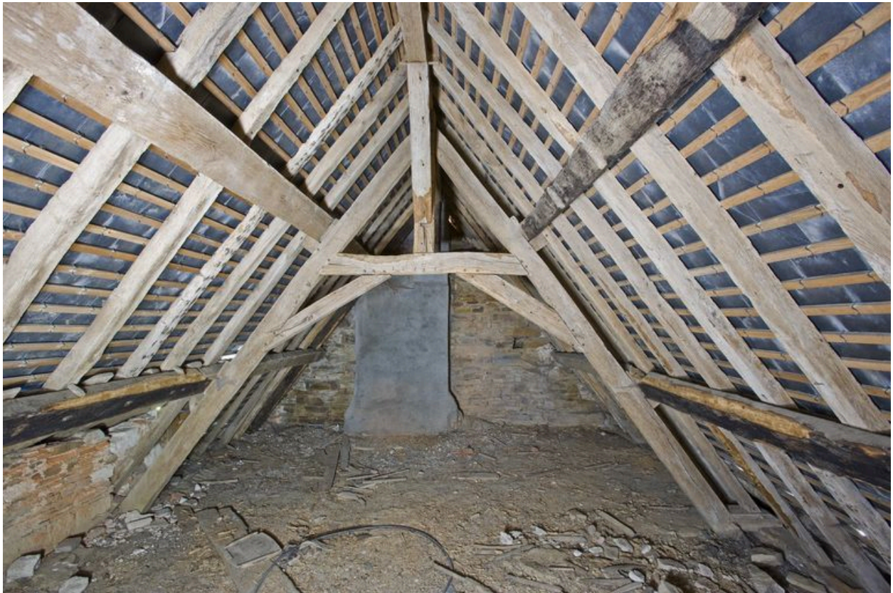
Charpente de l'aile nord.
