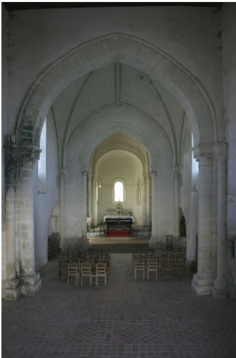
La nef : 2e travée voûtée.
