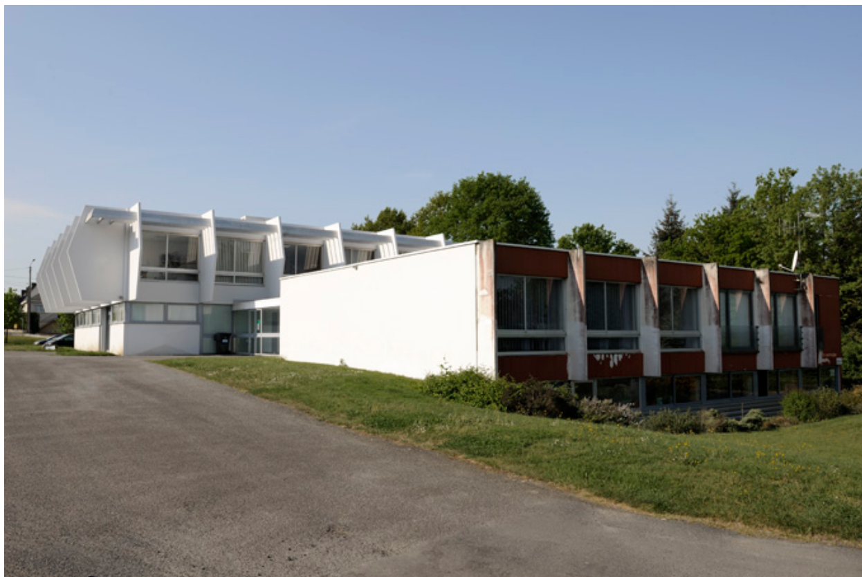
Siège du Groupe SAC : vue depuis le nord.
