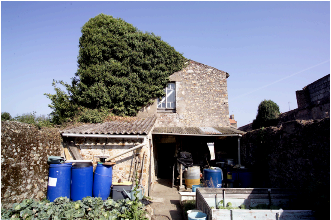
Vue de la façade sud depuis l'allée des Genêts.
