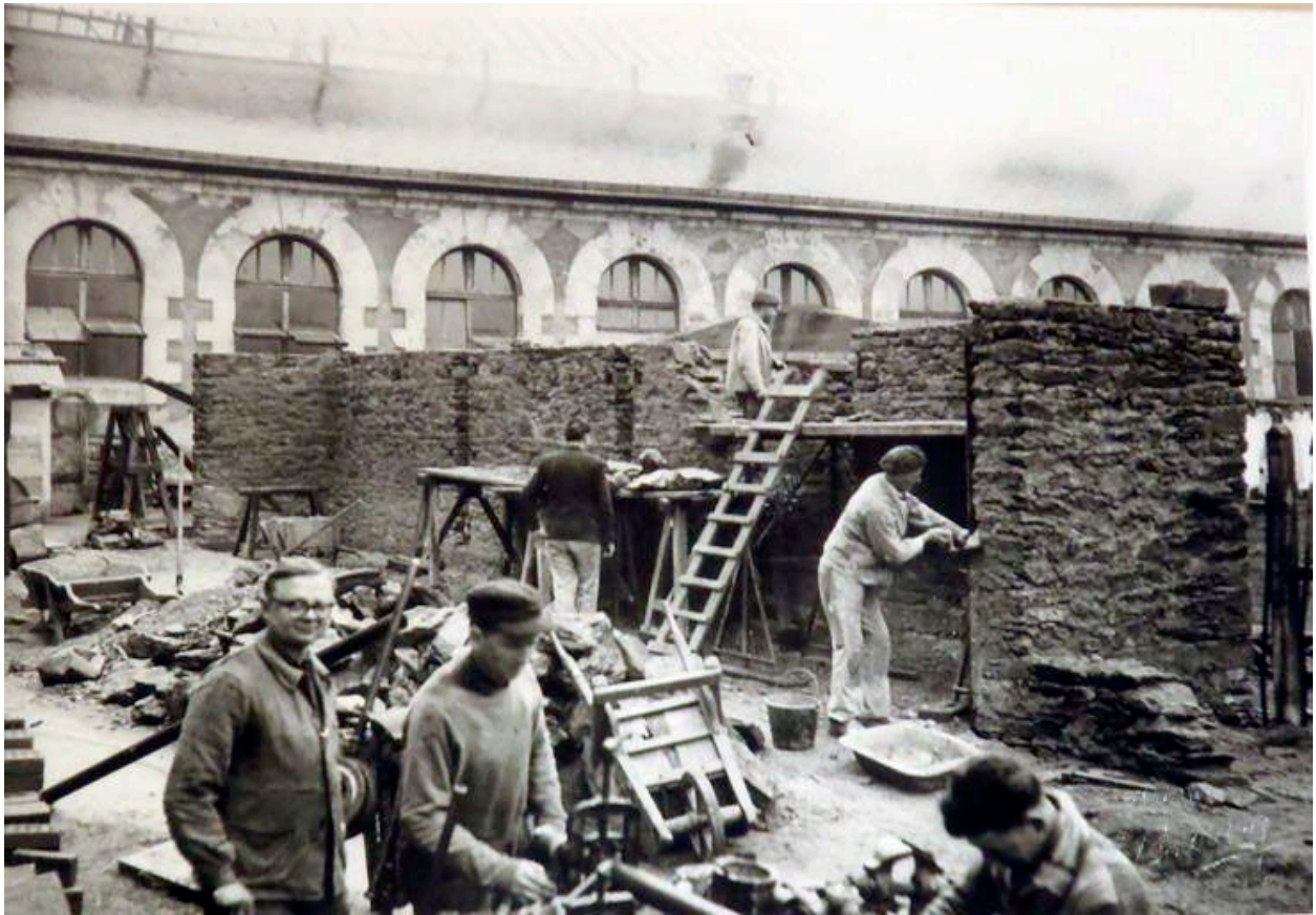
Construction des étendoirs, 1952.
