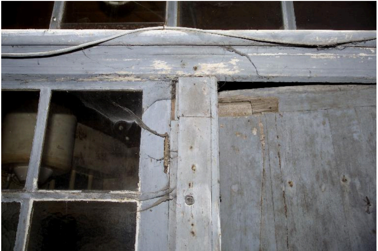
La porte d'accès à l'escalier, détail de la charpente.
