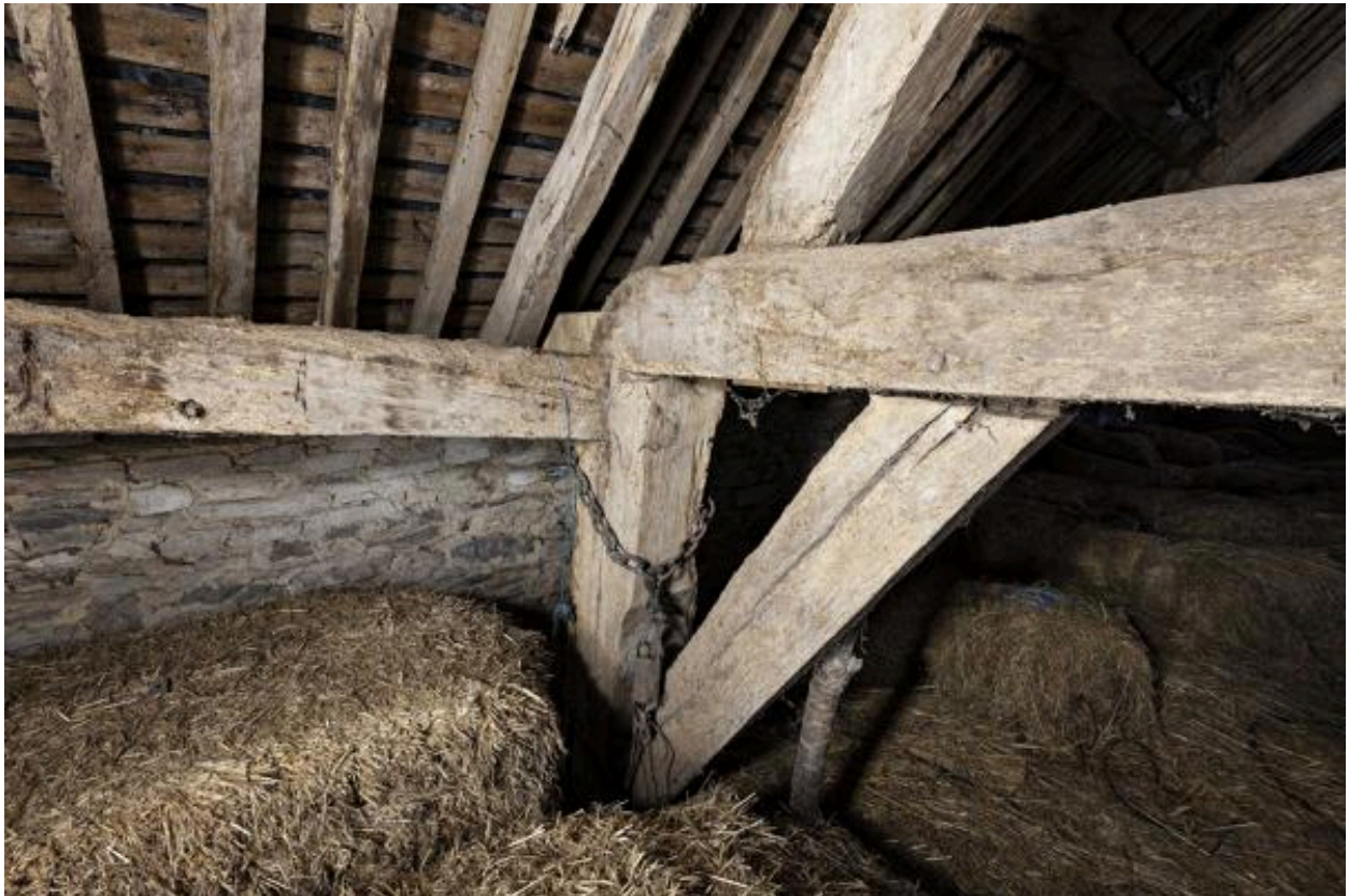
Ferme orientale, étable-grange, assemblage poteau, entrain, sablière.
