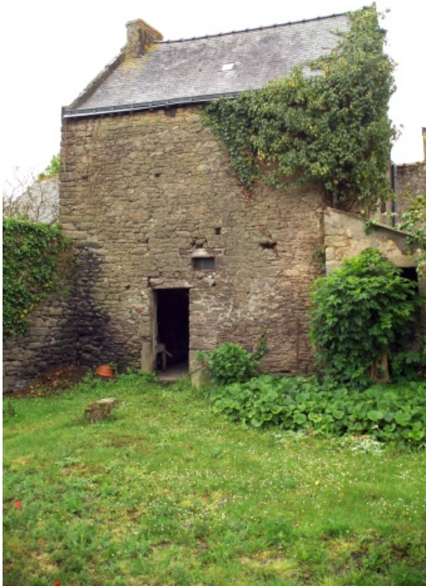
Vue du mur gouttereau de la dépendance est.
