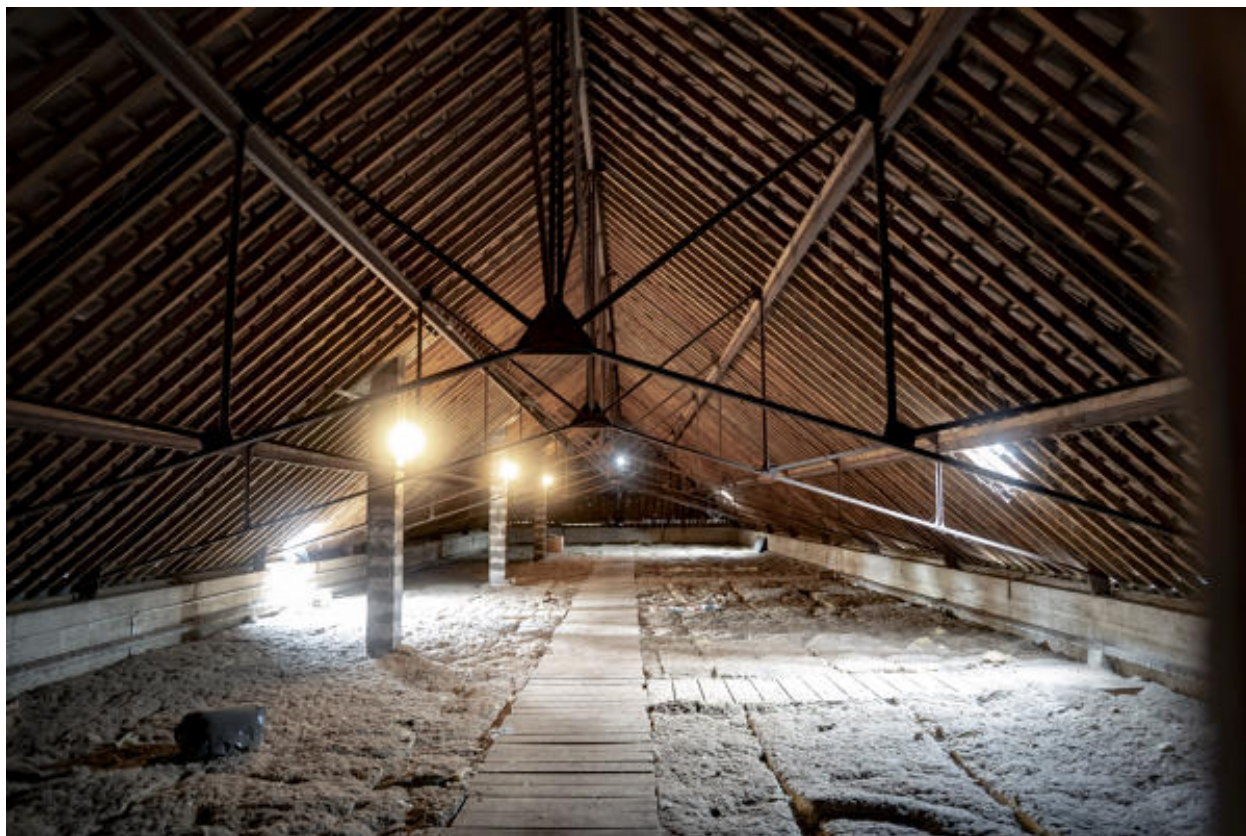
Vue de la charpente métallique.
