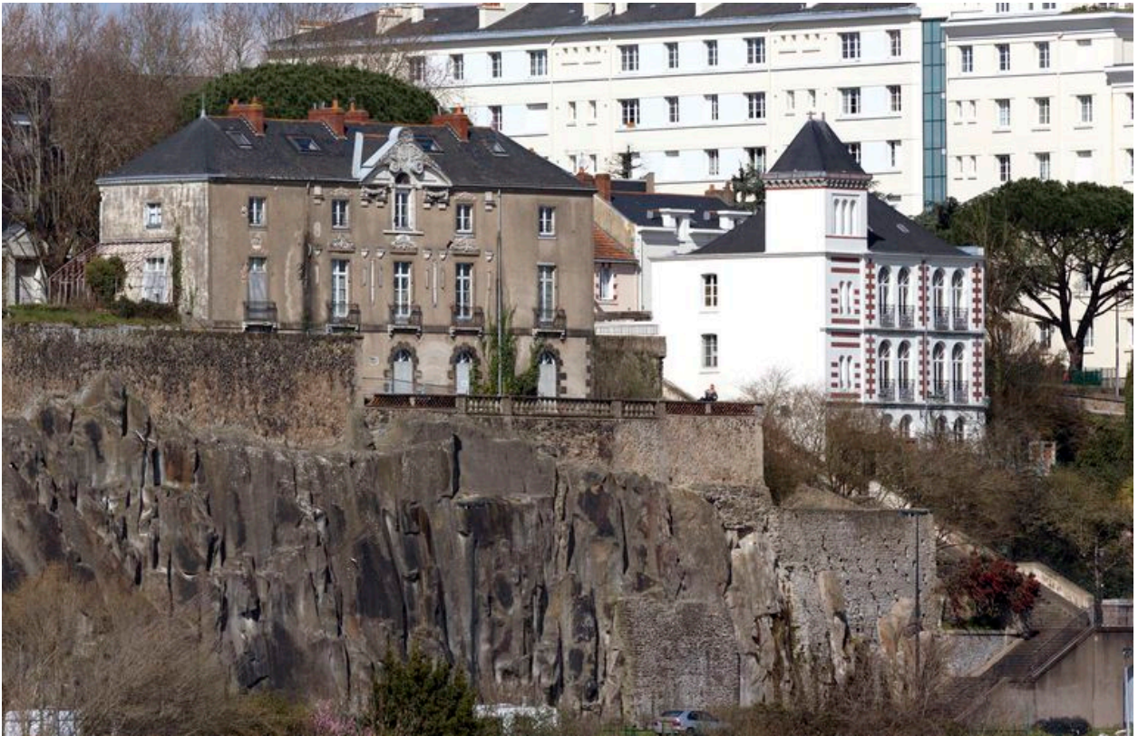
Vue générale avec l'ancienne serre, côté Loire.
