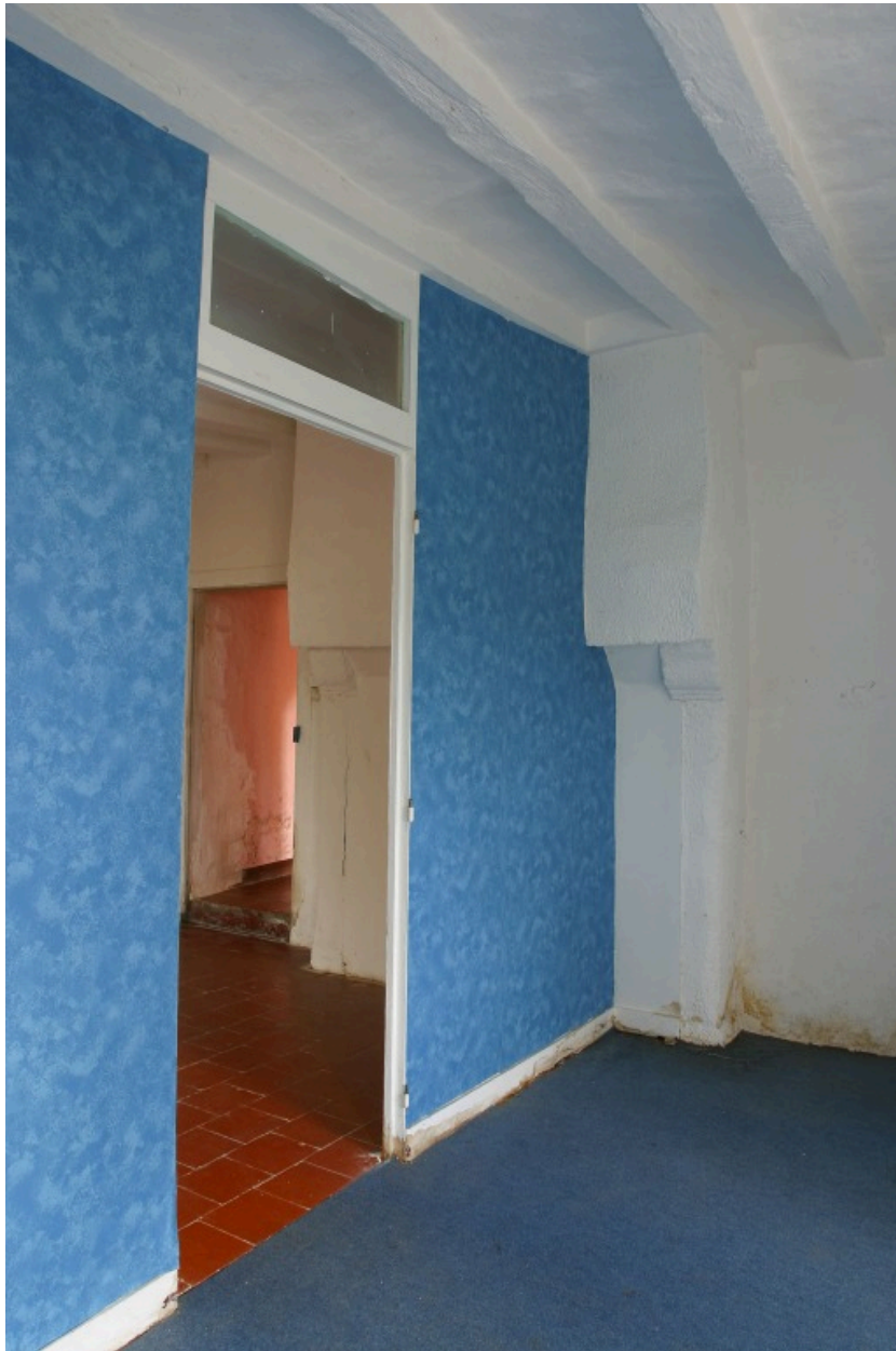
Etage de soubassement. Pièce 1A : la cheminée, située contre le mur nord.
