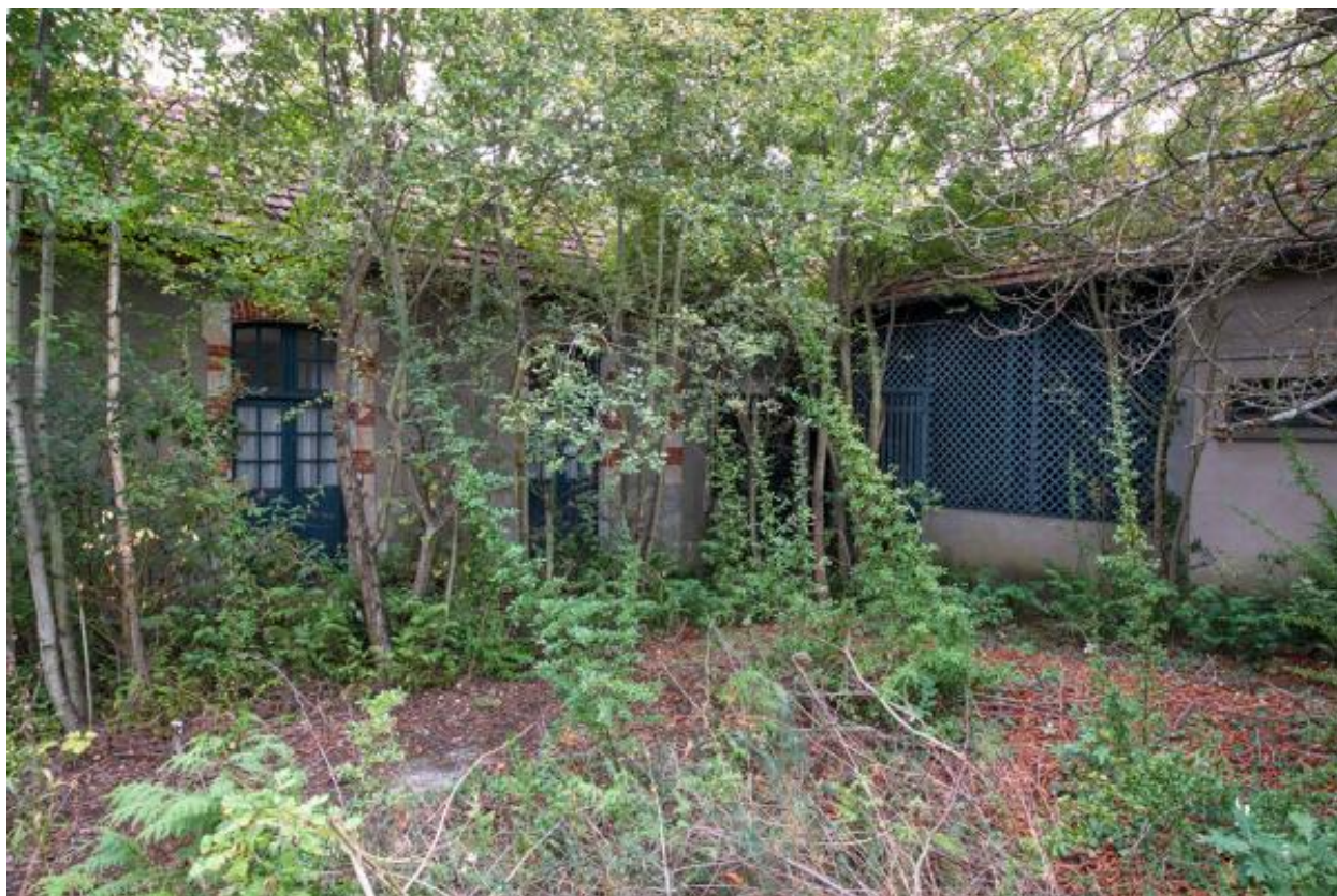
Vue des bâtiments de soins pour les chevaux.
