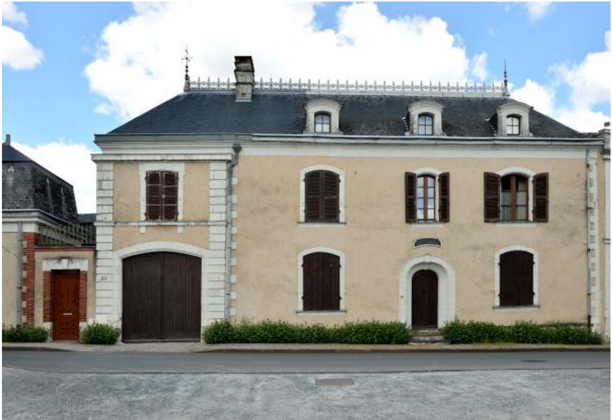
Vue de la maison dite Le Cloteau. 34 route de port-Thibault.
