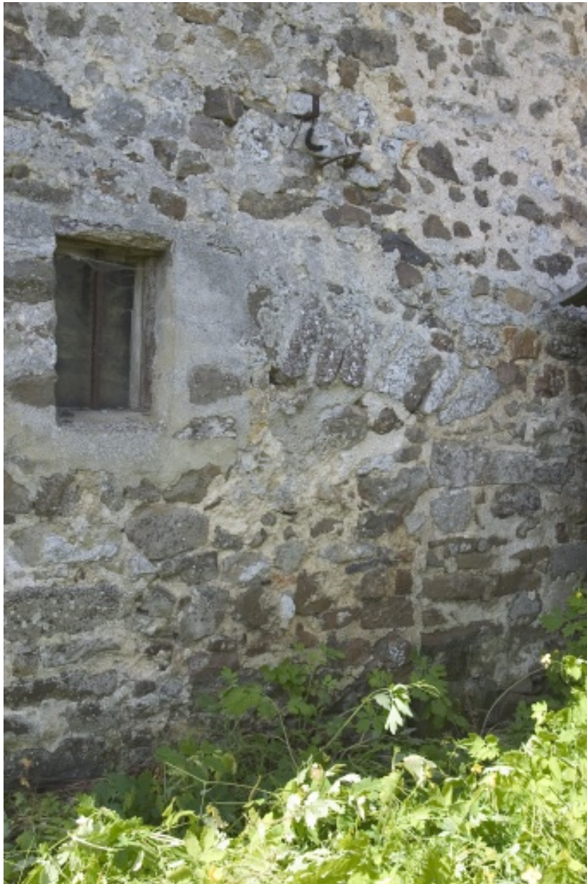
Détail de l'élévation nord : porte bouchée.
