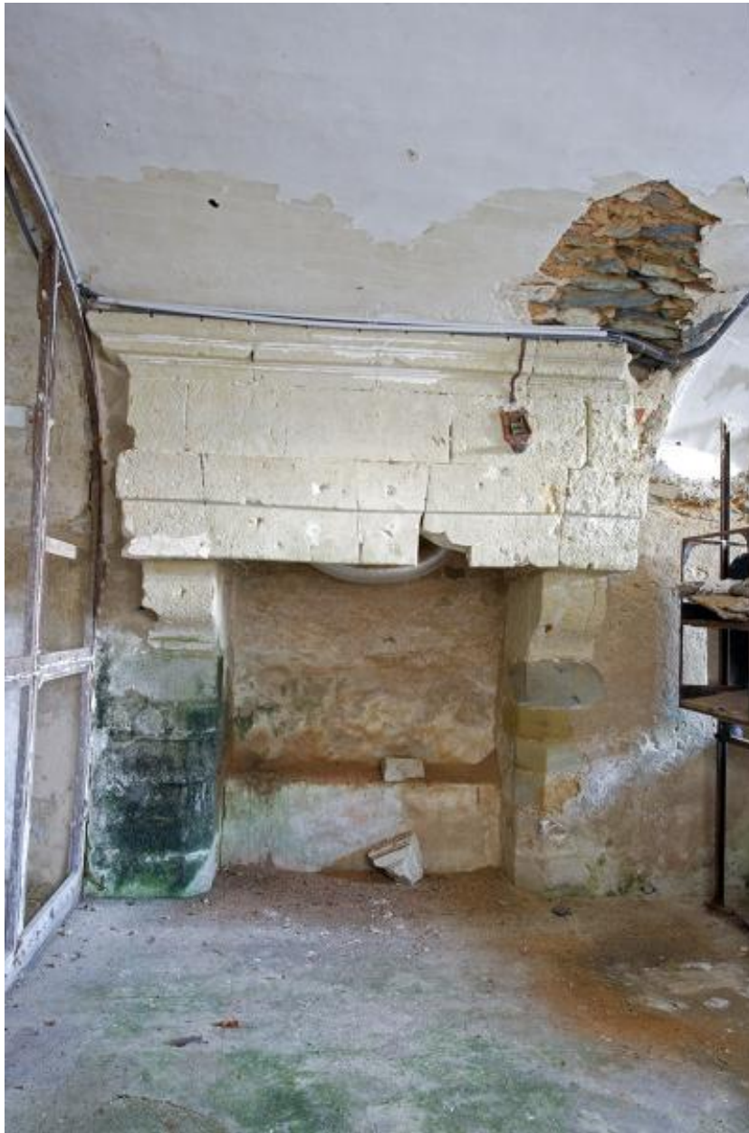
Une pièce du sous-sol, cheminée.
