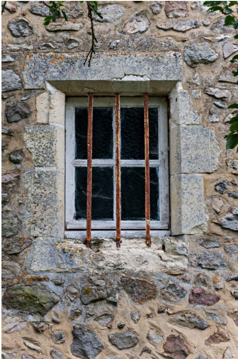
Fenêtre du mur-pignon droit.
