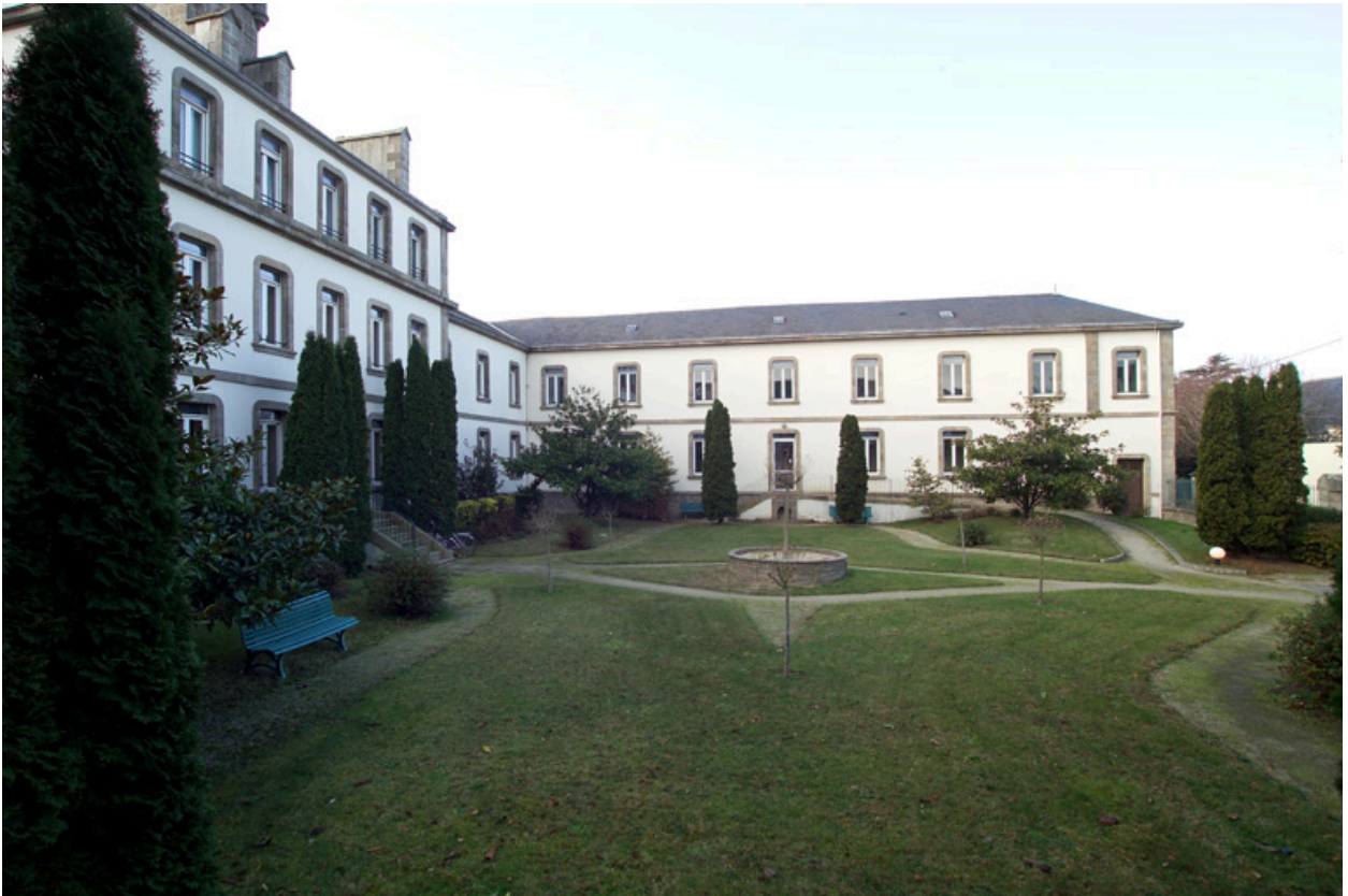
Aile occidentale vue depuis l'est.
