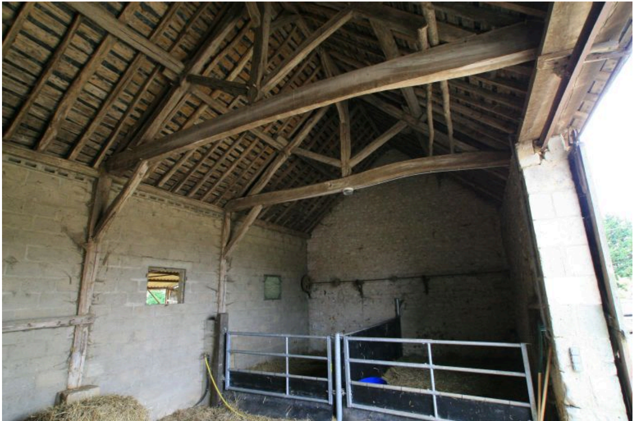
La grange méridionale : charpente sur poteaux.
