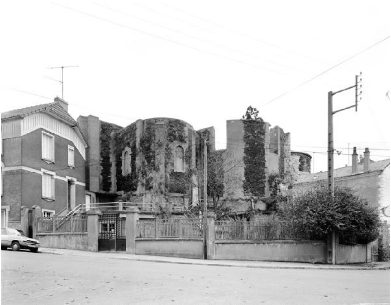
Chevet : vue de situation au sud-est.
