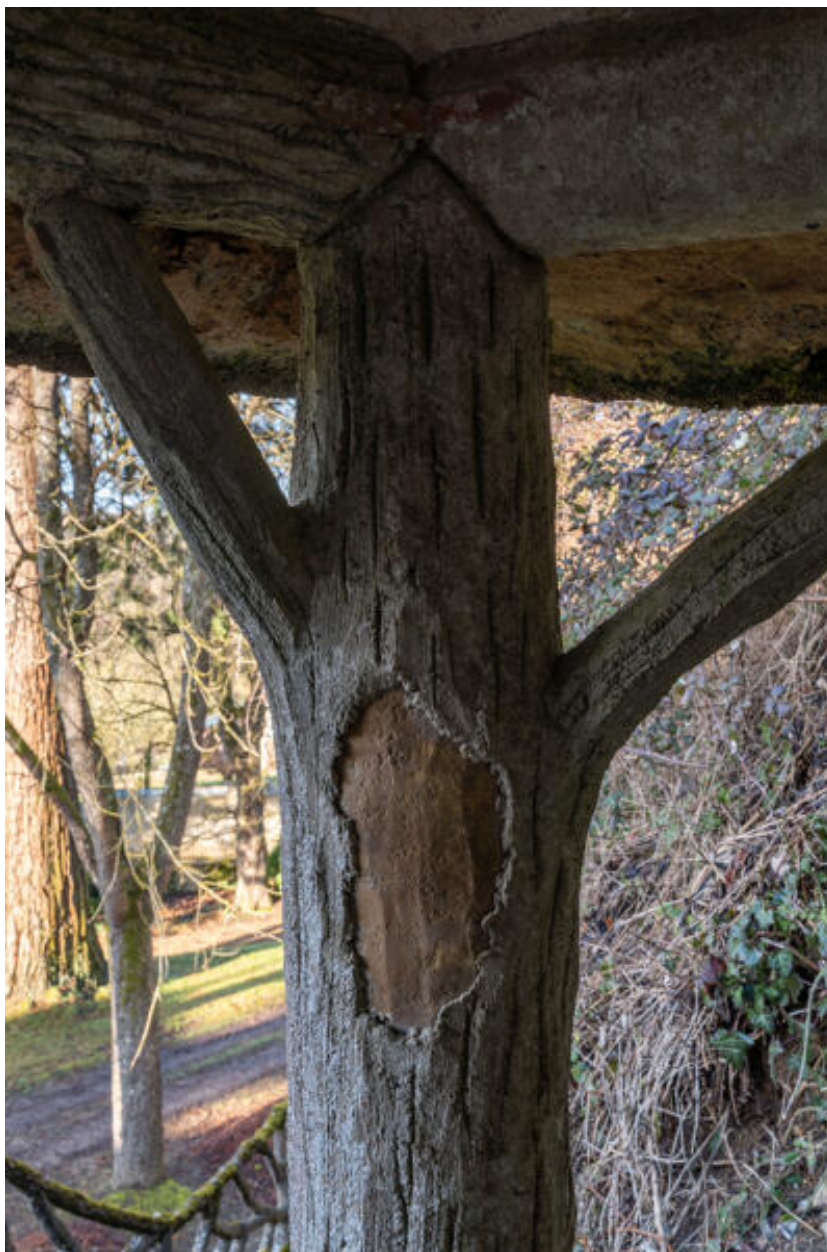
Fabrique de jardin en béton rustiqué : détail.
