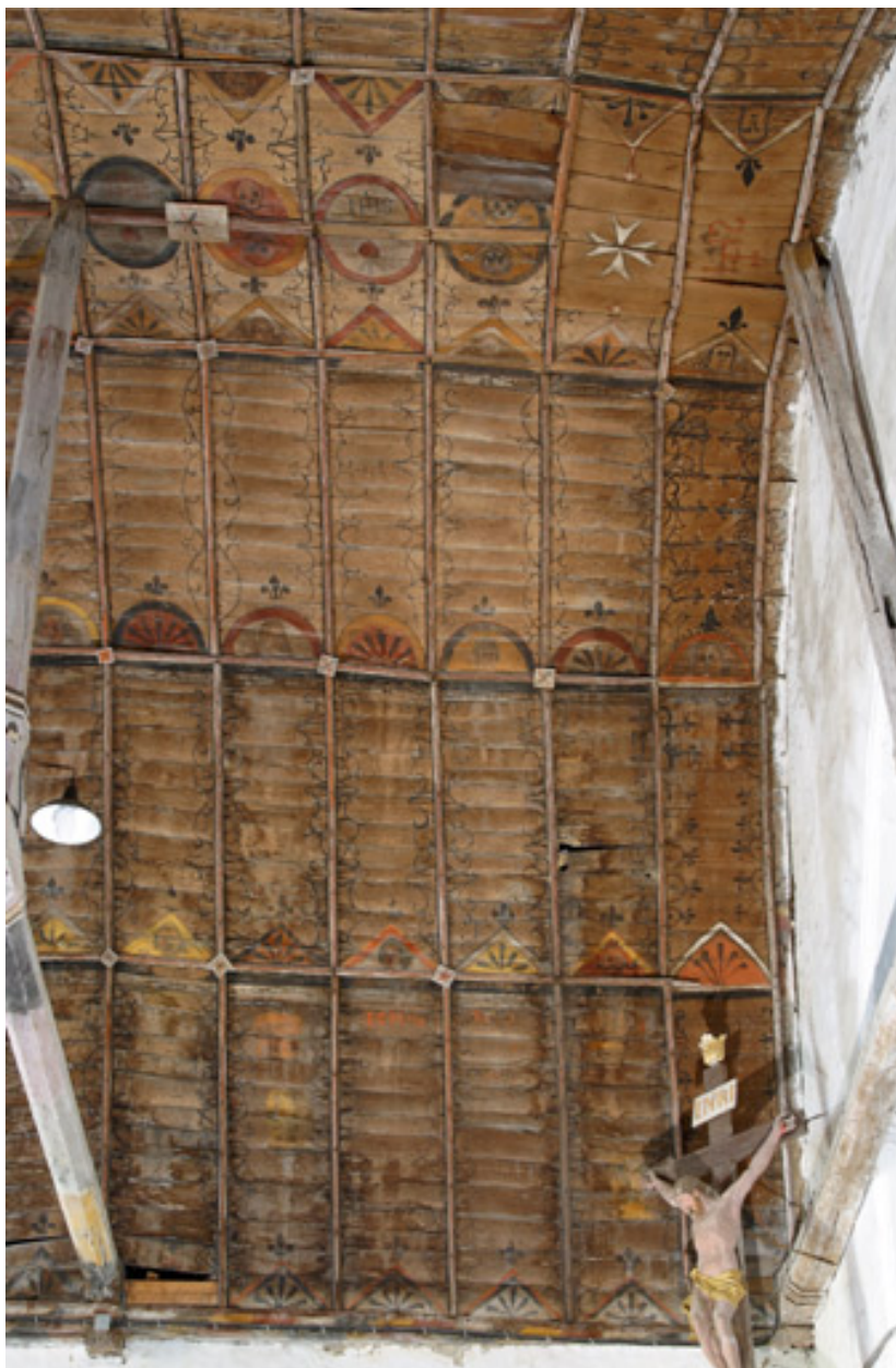
Nef, voûte, côté nord, quatrième travée : vue d'ensemble.
