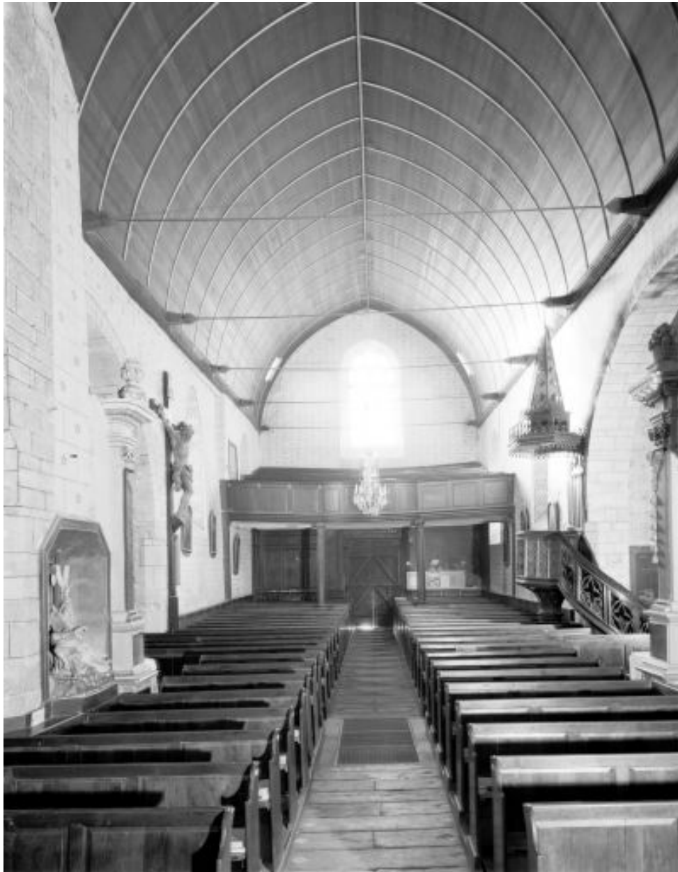
La nef vue depuis le chœur.
