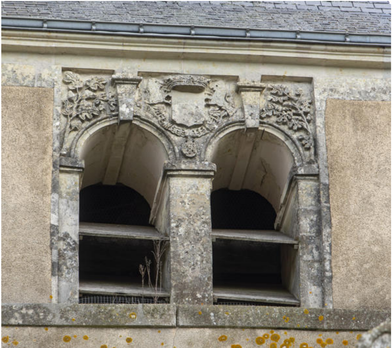
Les baies du clocher.
