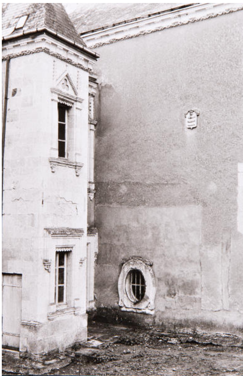
Élévation nord-est, détail : tourelle ajoutée fin XIXe s.
