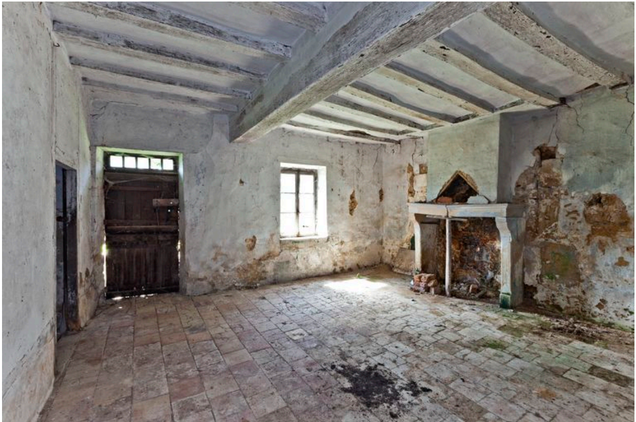
Vue intérieure de la pièce gauche.
