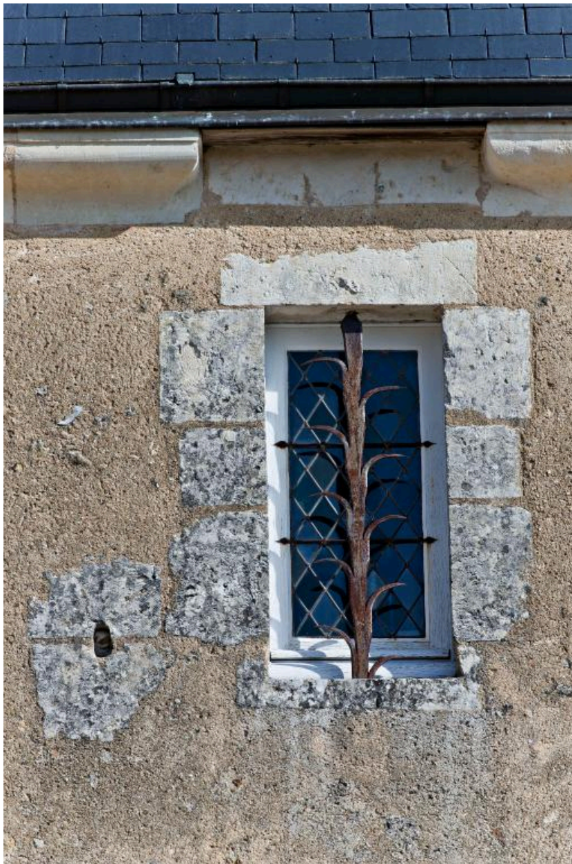
Pavillon d'angle sud-ouest bastionné : détail de la baie d'étage au sud.
