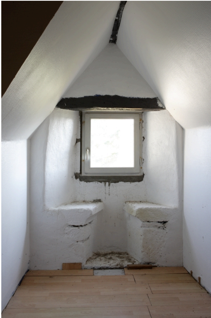
Aile ouest. Étage de comble. Vue de la lucarne à cousièges.
