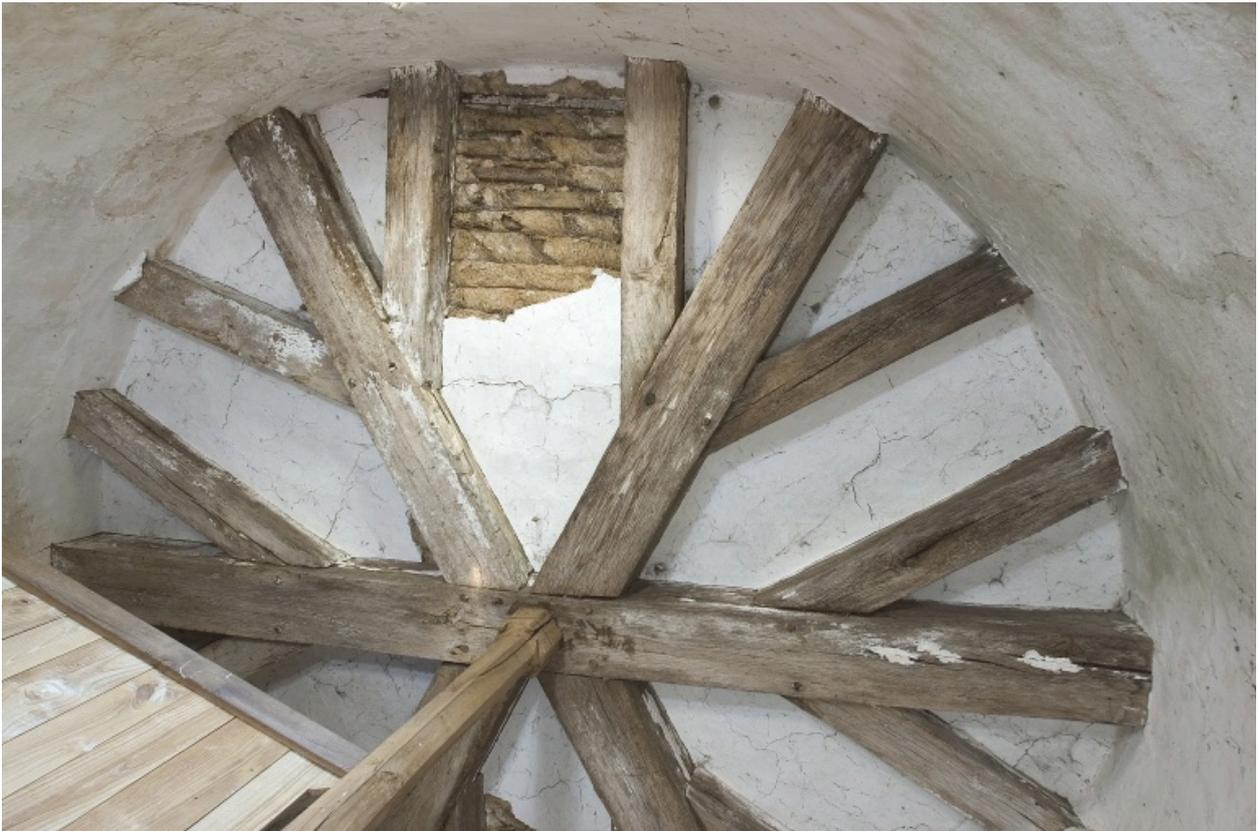
Intérieur du logis : partie inférieure de la charpente de la tour, servant de plancher à la salle sous comble.
