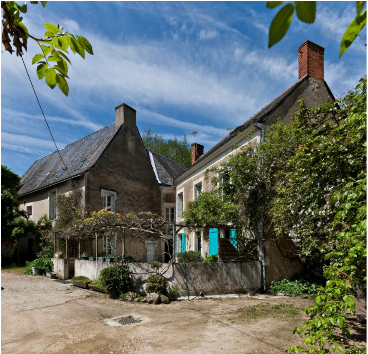
Vue de volume du moulin et de la maison.
