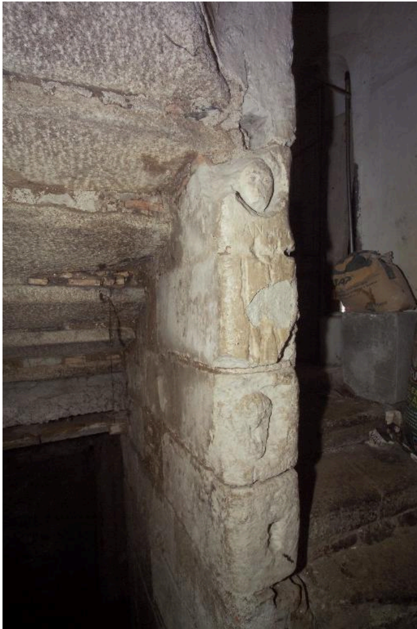
Le mur noyau de l'escalier, la volée d'accès au niveau des caves.
