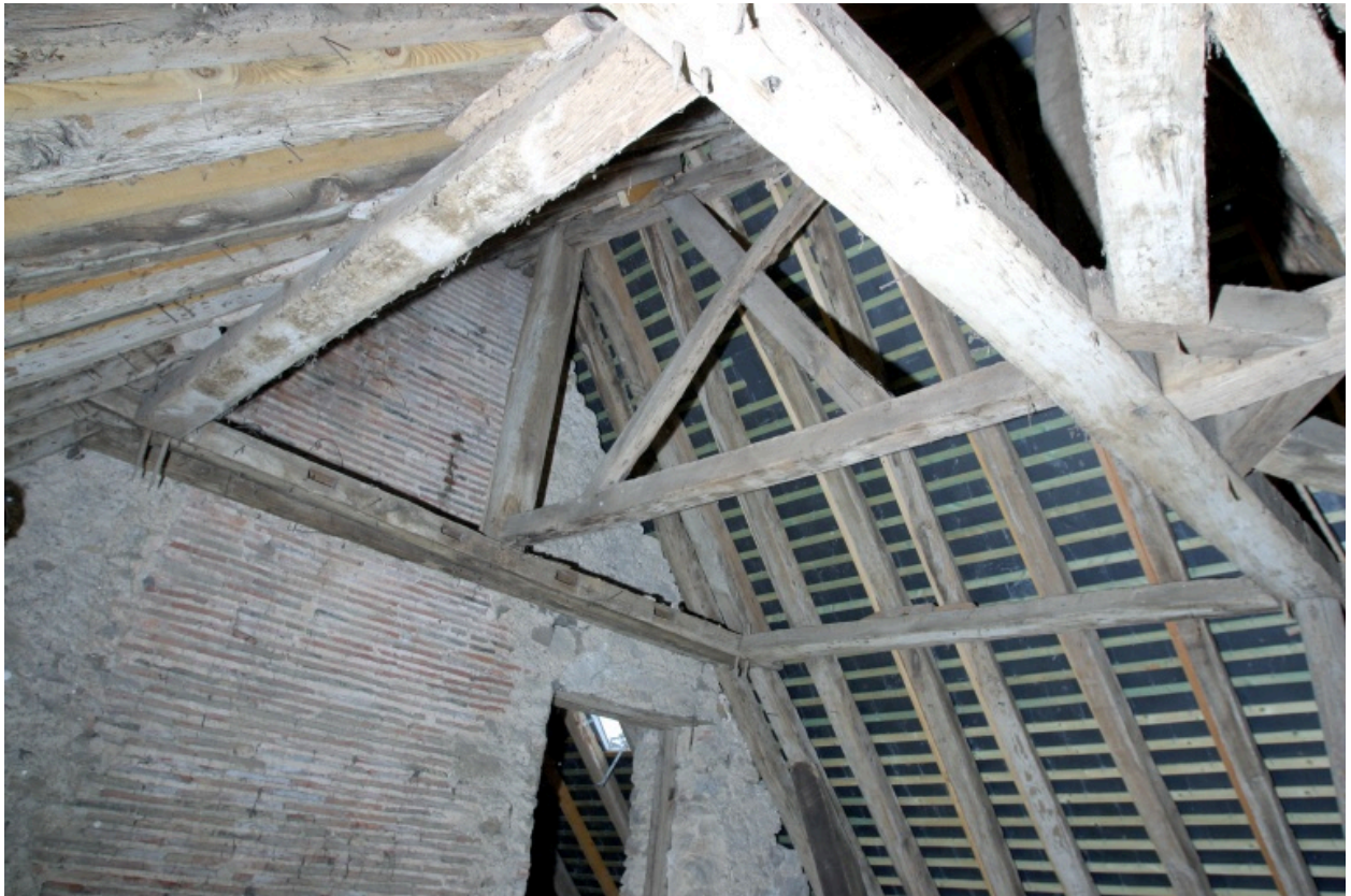
La charpente de la partie sud vue depuis le sud.
