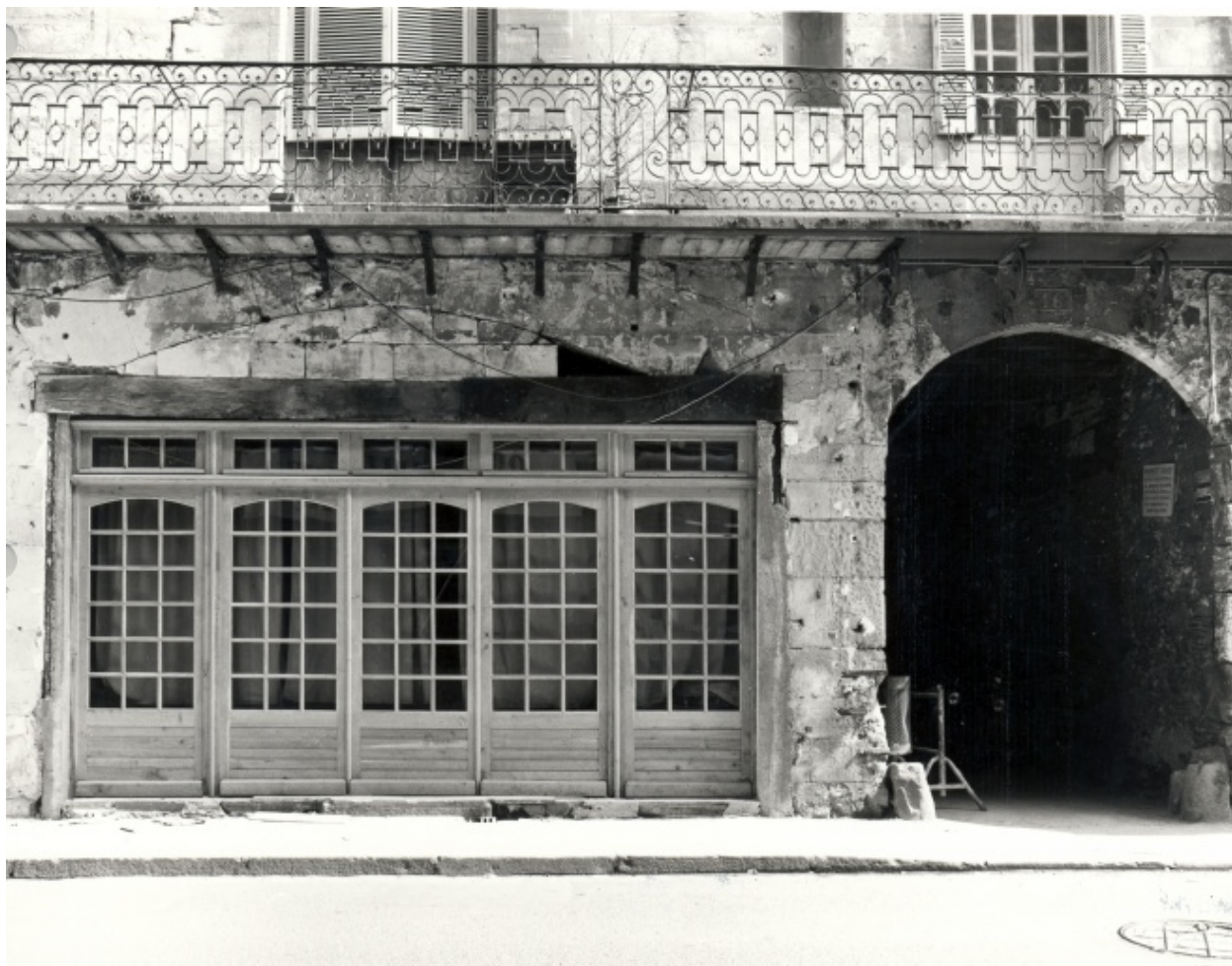
Façade sur rue, 1er niveau (traces de l'ancienne boutique et passage couvert desservant le logis et la cour des Tourelles) et balcon du premier étage.
