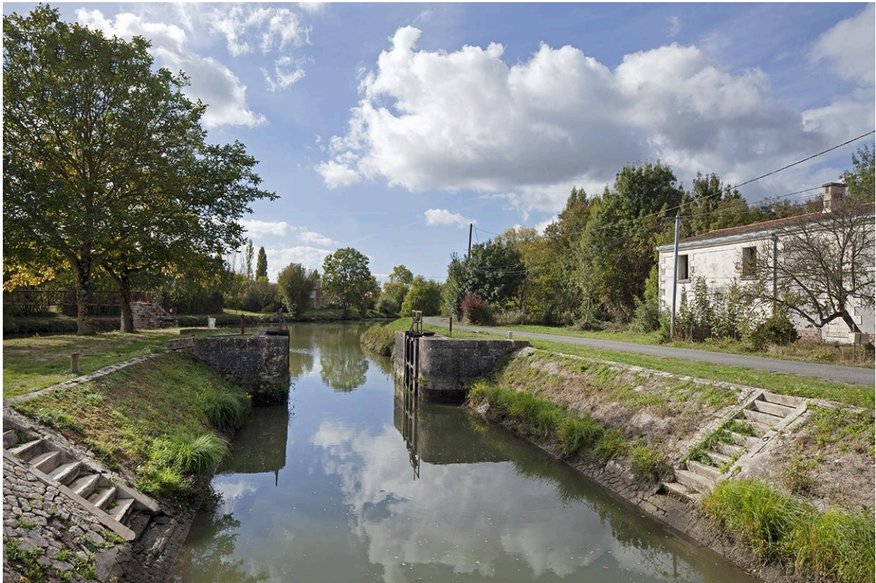
L'écluse de la Vieille Sèvre avant restauration, en 2016.
