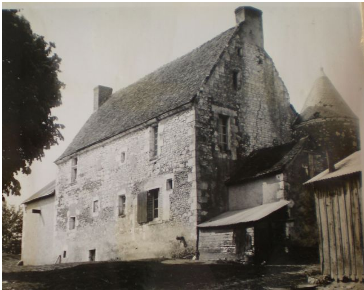
Façade postérieure avant restauration en 1948.
