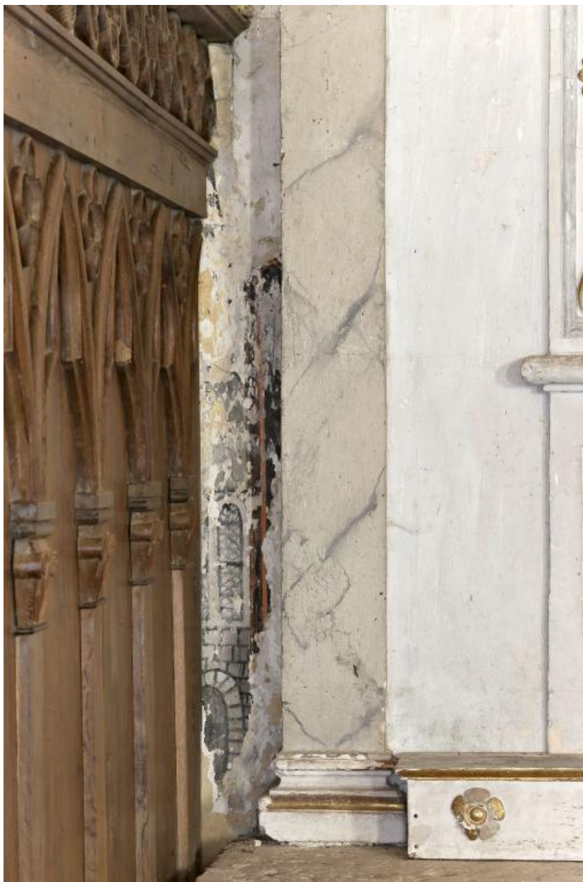
Chœur, mur oriental, côté nord, partie inférieure du mur : détail d'un élément d'architecture.
