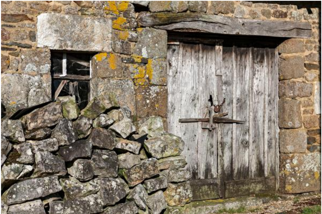
Hameau du Baz-Hazay, porte et fenêtre de l'ancienne maison de l'alignement nord, transformée en remise.
