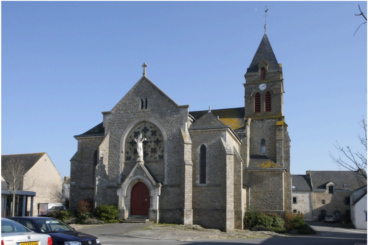
Vue de la façade occidentale.
