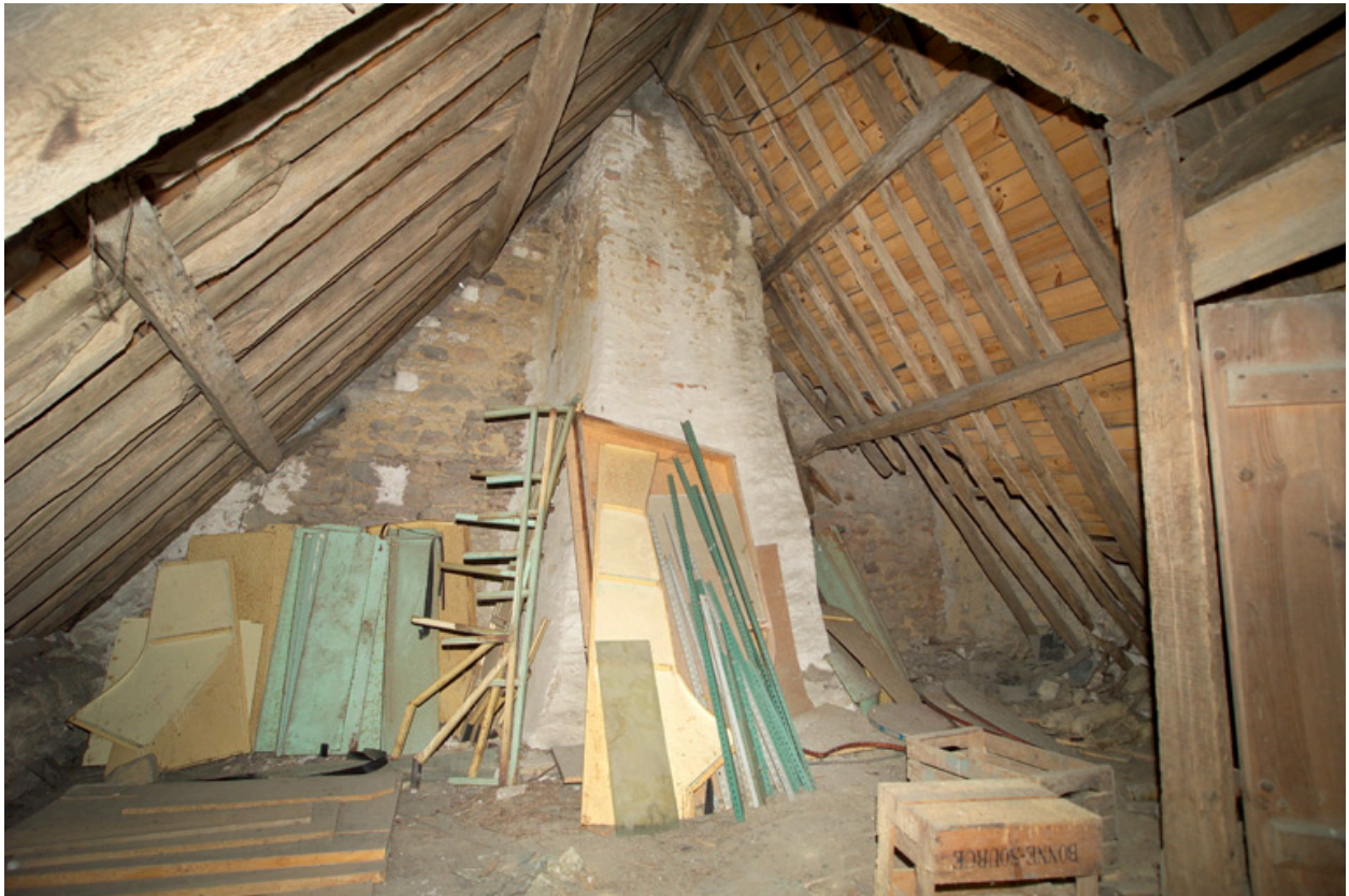
Corps principal, combles, vue générale.
