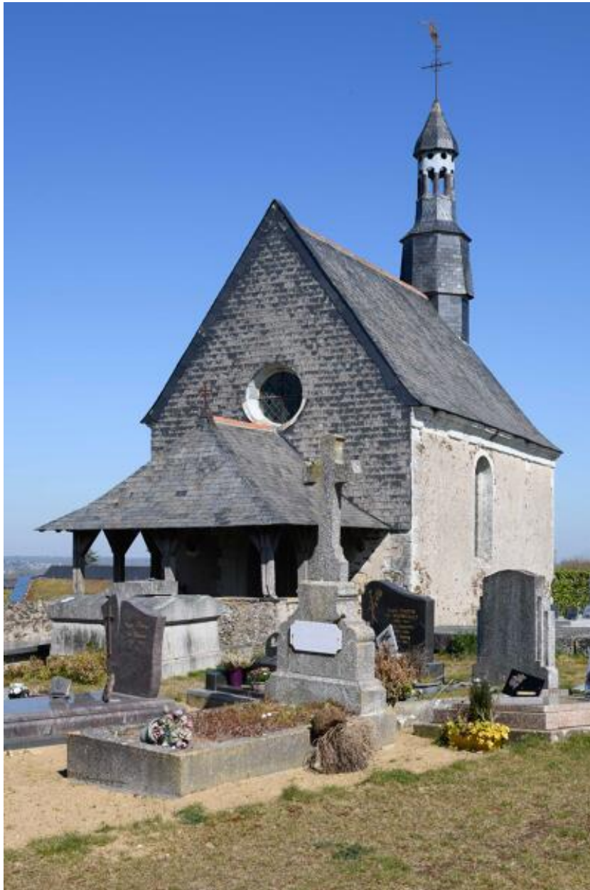
Vue de la chapelle depuis le sud-est.
