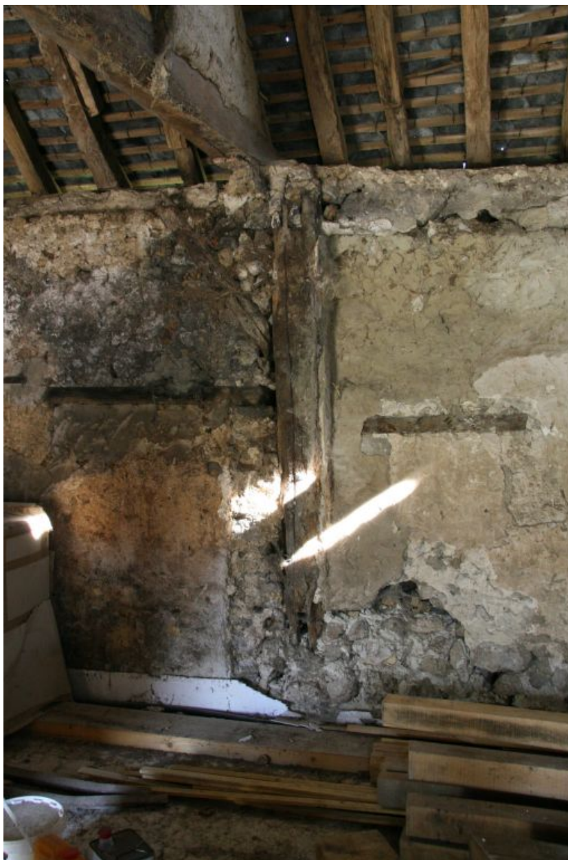
Les dépendances : vestige d'un poteau dans la maçonnerie.
