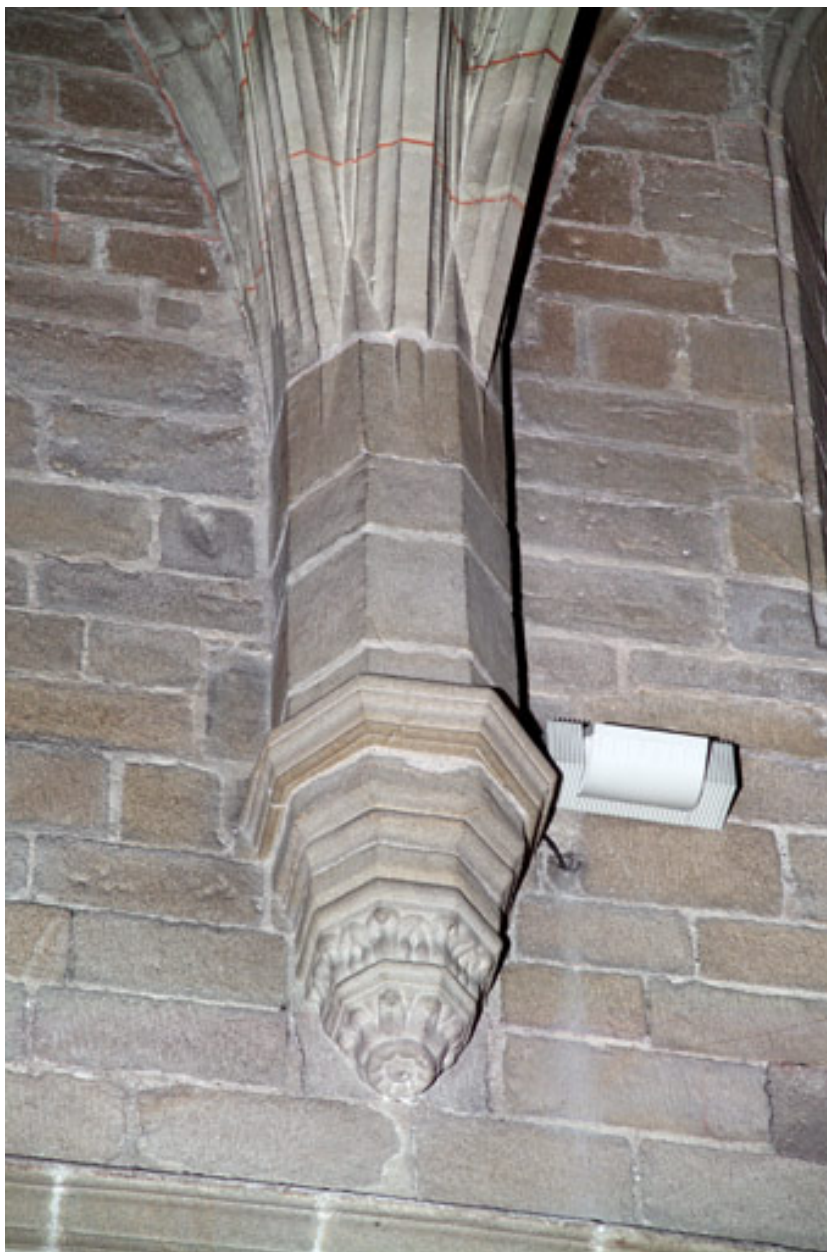
Culot sculpté recevant les nervures d'une voûte du chœur.
