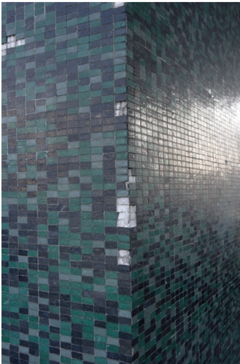
Bâtiment administratif, détail du revêtement de pâte de verre.
