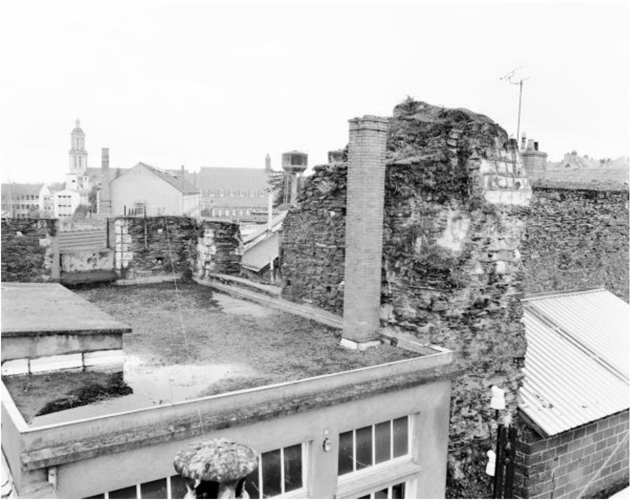
Transept, bras sud : vestiges des faces intérieures sud (à gauche) et ouest (à droite), avec les restes des fenêtres arasées.
