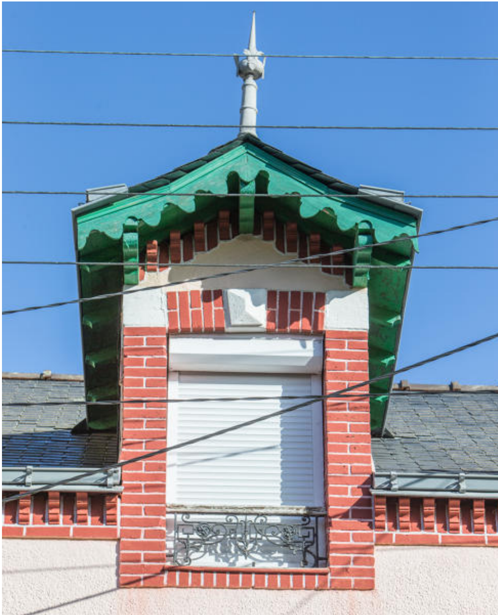
Maison, 19 quai Henri-Brunais. Détail de la lucarne.
