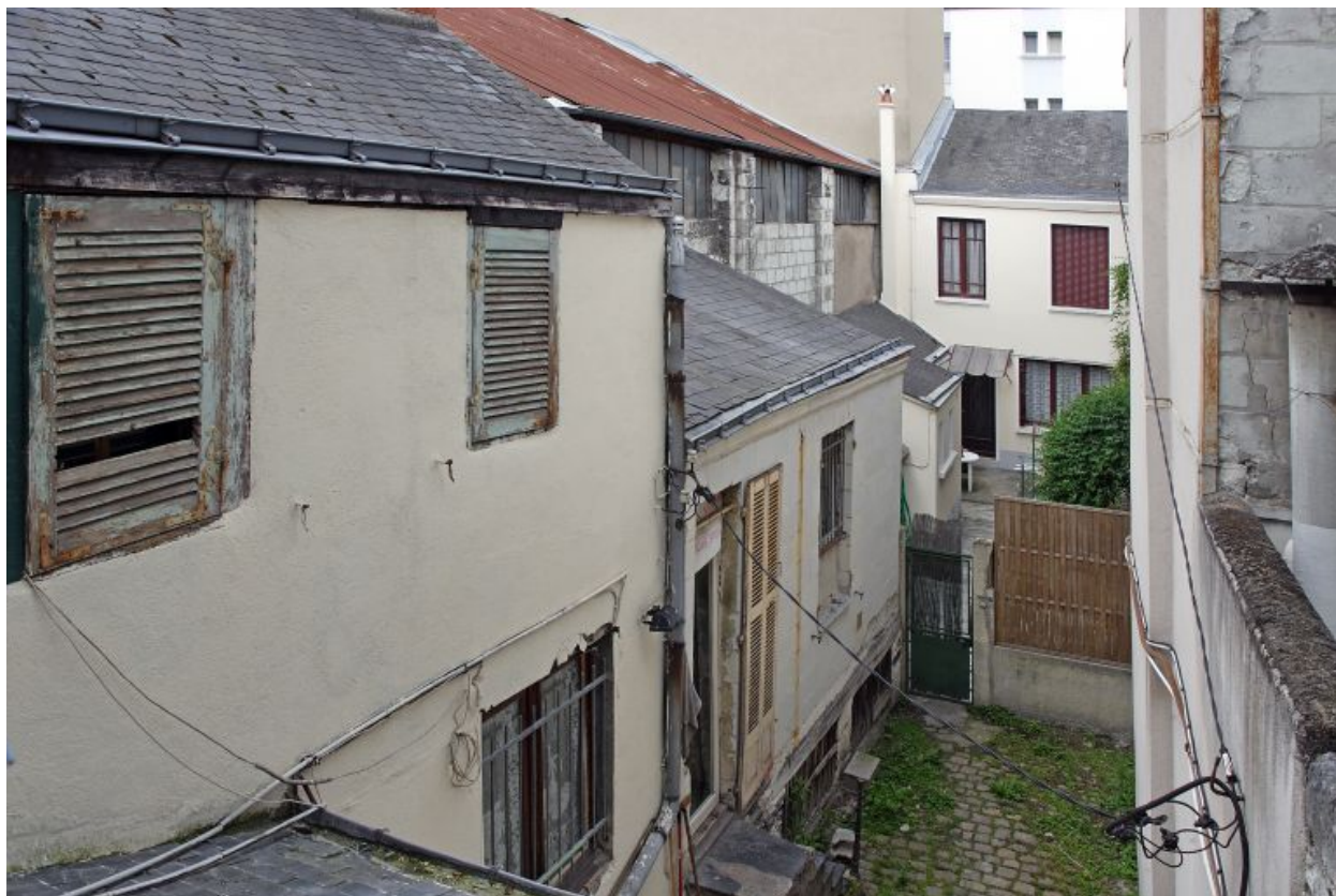
Corps secondaire en retour et la cour arrière, vue depuis le 1er étage du corps principal.
