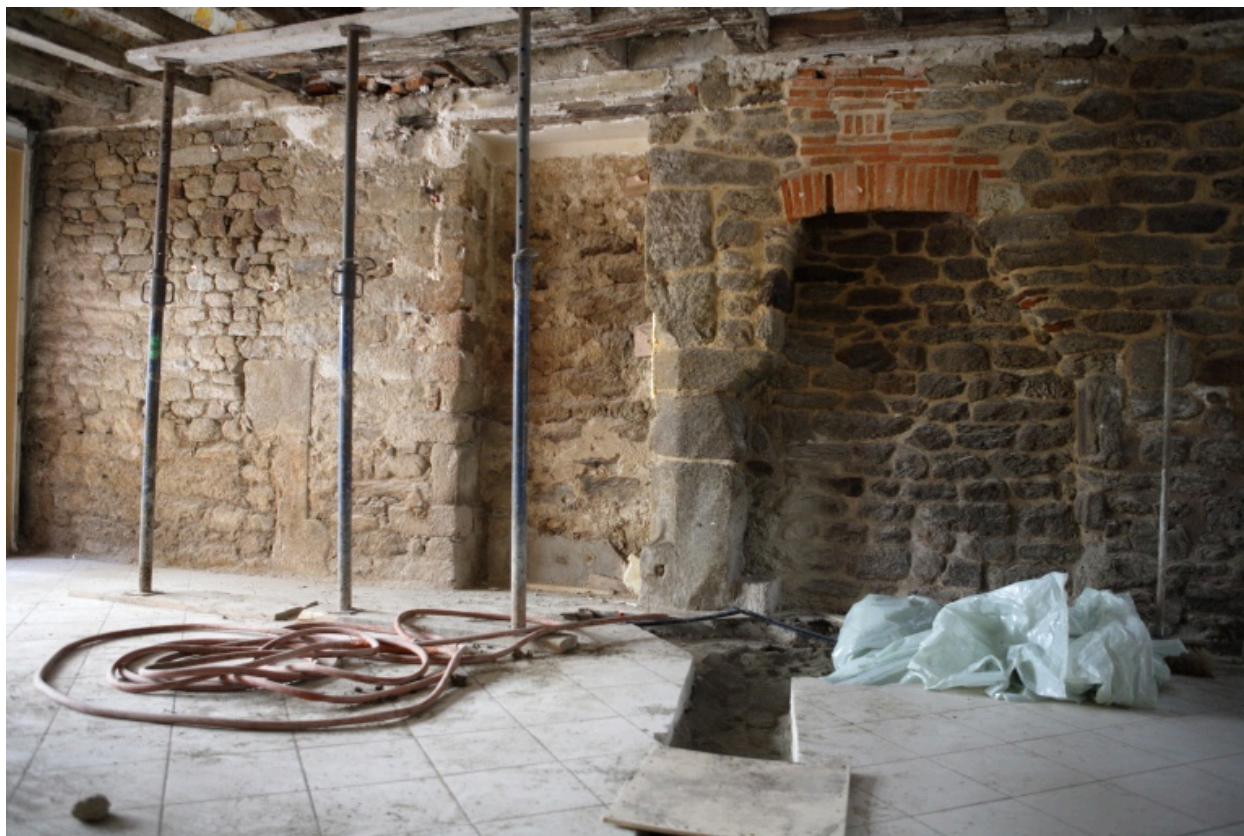
Partie donnant dans la rue Saint-Michel, mur gouttereau est.
