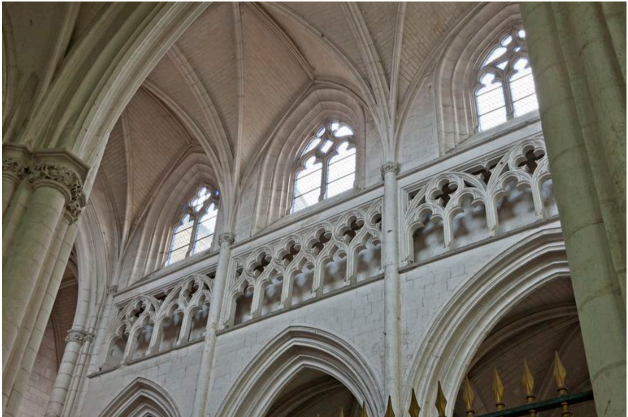
Elévation nord (parties hautes) des trois premières travées du chœur.
