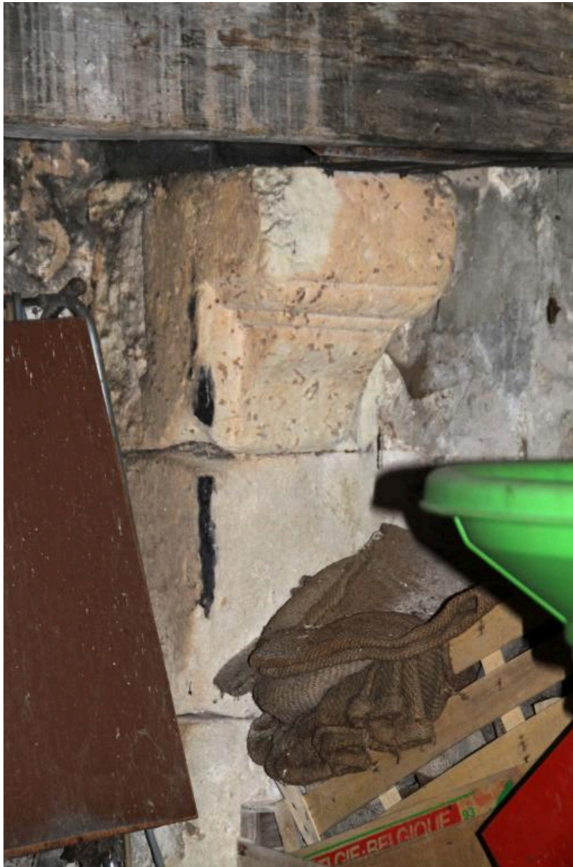
Buanderie : détail du corbeau gauche de la cheminée.
